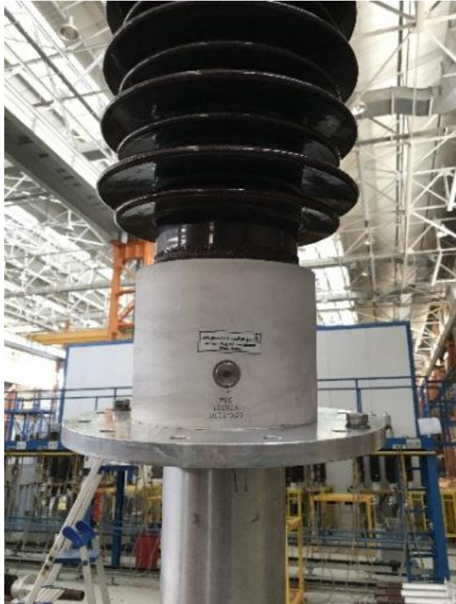
شکل ۵۶ پیچ هواگیری برای خارج نمودن هوای محبوس شده در ترانس از زیر فلنج بوشینگ
