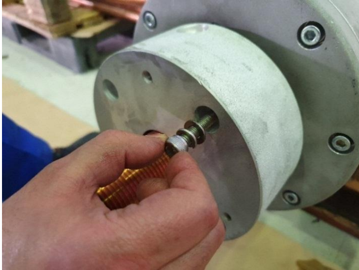
شکل ۲۹ - بازکردن پیچ های آلن و جدا نمودن قطعه "Top Flange" از قسمت فوقانی بوشینگ
