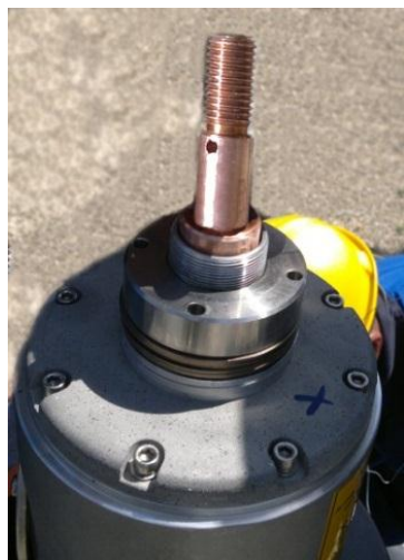
شکل ۳۳ عبور دادن هادی مسی از داخل پوشینگ برای نصب آن بروی ترانس
