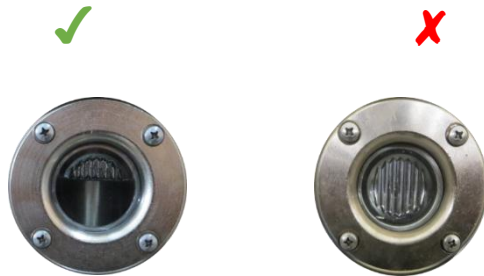
شکل ۵۷ وضعیت شیشه روغن‌نما در شرایط معمول کارکرد بوشینگ (چپ) و وضعیت هشدار (راست) Fig. 57 Normal (left) and dangerous (right) state of sight glass
