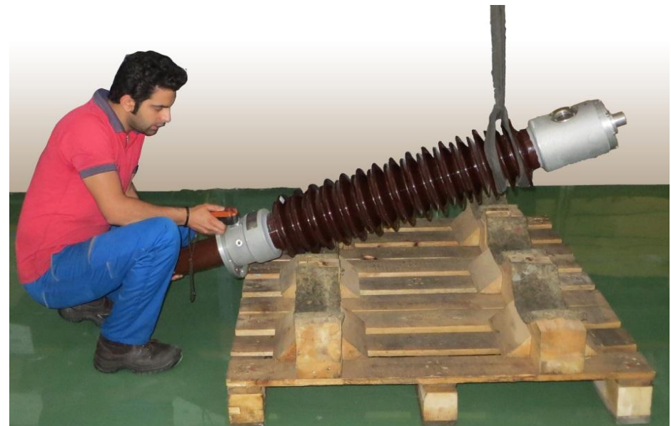
شکل ۱۳ الف بلند کردن و عمودی نمودن پوشینگ مدل NGB1 Fig. 13.A Lifting and erecting bushing type NGB1
