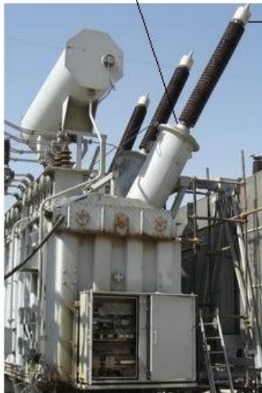
شکل ۴۱ نحوه ی نصب صحیح بوشینگ تحت زاویه بر روی ترانسفورماتور
