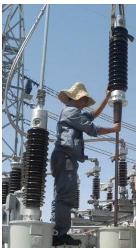
شکل ۳۳ عبور دادن هادی مسی از داخل پوشینگ برای نصب آن بروی ترانس
