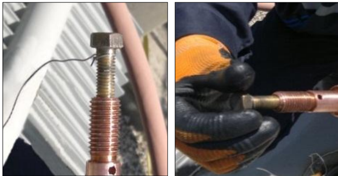
شکل ۳۸ پیچاندن پیچ M12 داخل سوراخ رزوه شده بالایی سرکابل و اتصال سیم کمکی به آن Fig. 38 Screwing a M12 bolt into draw-lead top bore and connecting a helping wire
