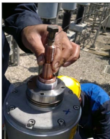
شکل 37- بیرون کشیدن سرکابل مسی از بالای پوشینگ
