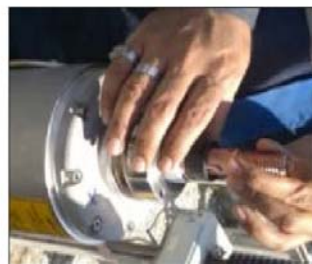
شکل 14- درآوردن گسکت از روی سرکابل
