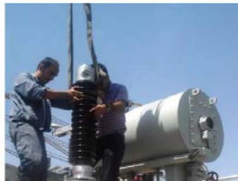
شکل 20- بلند کردن بوشینگ قدیمی از محل نصب به کمک جرثقیل
