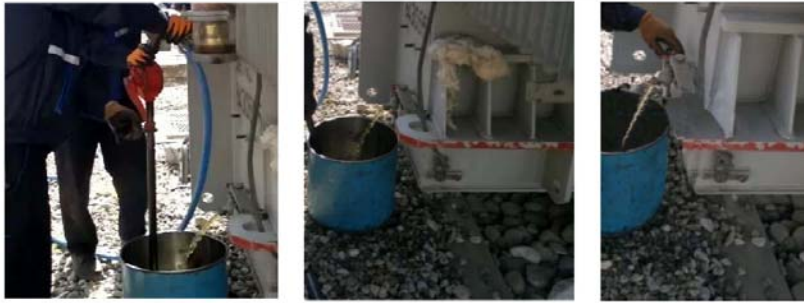
شکل 1- تخلیه مقداری از روغن ترانس و انتقال آن به محفظه کانسرواتور
