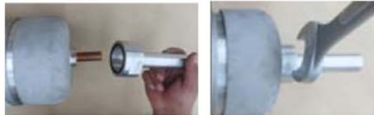
شکل 11- باز نمودن ترمینال HV از روی پوشینگ
