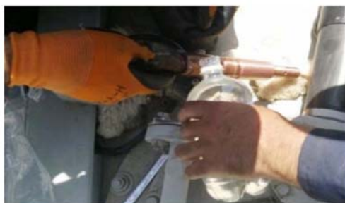
شکل 33- تمیز کردن مجموعه سوزنی‌ها پیش از نصب پوشینگ
