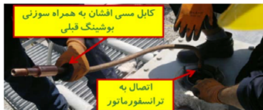
شکل 22- سوزنی بوشینگ قدیمی و کابل مسی متصل به ترانس
