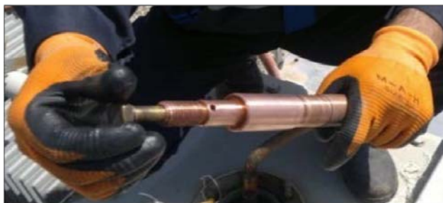
شکل 34- بستن پیچ M12 به داخل سوراخ رزوه شده سر سوزنی
