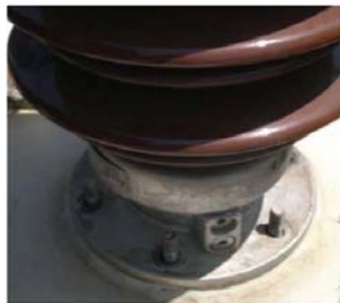
شکل 18- باز نمودن مهره پیچ‌های فلنج اتصال بوشینگ به ترانس
