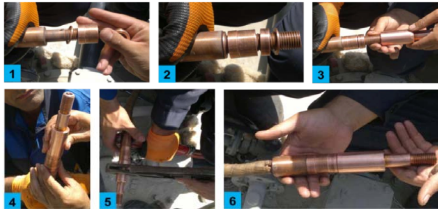
شکل 32- قرار دادن واشرهای مسی در فضای خالی بین دو سوزنی و سفت نمودن سوزنی‌ها به هم
