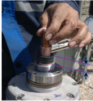
شکل 26- اندازه‌گیری طول اضافی سوزنی قدیمی
