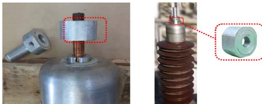
شکل 29- تکه پایینی ترمینال HV بوشینگ قدیمی
