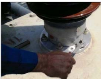
شکل 38- بستن مهره‌های نصب پوشینگ روی ترانس
