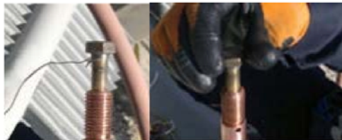
شکل 19- بستن پیچ M12 به داخل سوراخ رزوه شده سر سوزنی و اتصال سیم کمکی به آن
