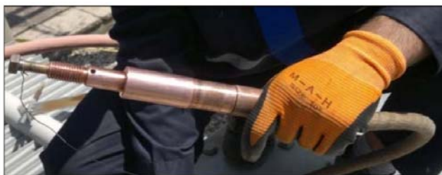
شکل 35- اتصال سیم کمکی به پیچ M12 متصل شده به سوزنی
