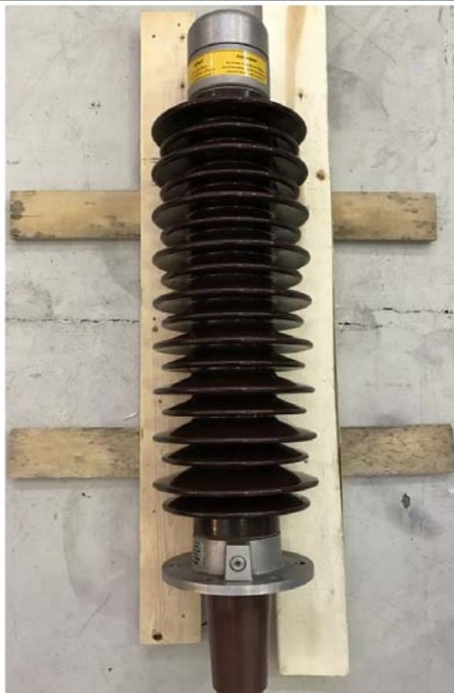
شکل 21- انتقال بوشینگ قدیمی به پایین ترانس
